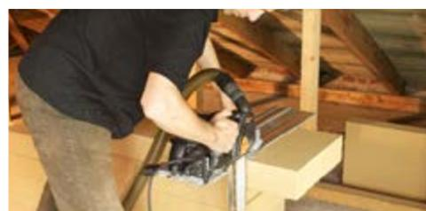
Grazie alle loro dimensioni di 1200 x 400 mm i pannelli Fibertherm top possono facilmente passare attraverso gli accessi al sottotetto.
